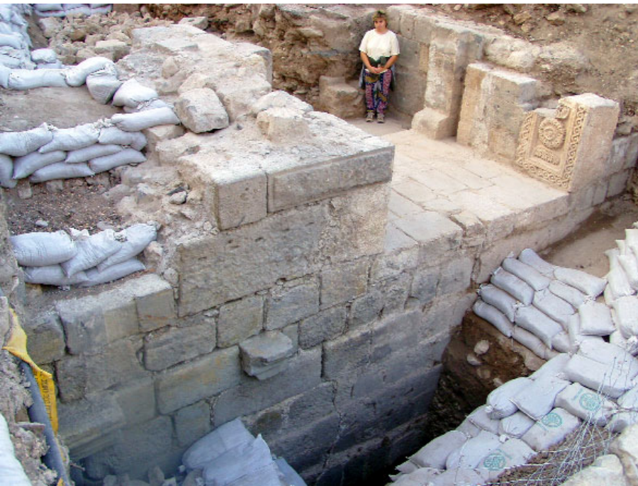
Abb. 9: Portal in der Nordmauer der Kreuzfahrerzitadelle nach Freilegung, Blick von Nordosten
